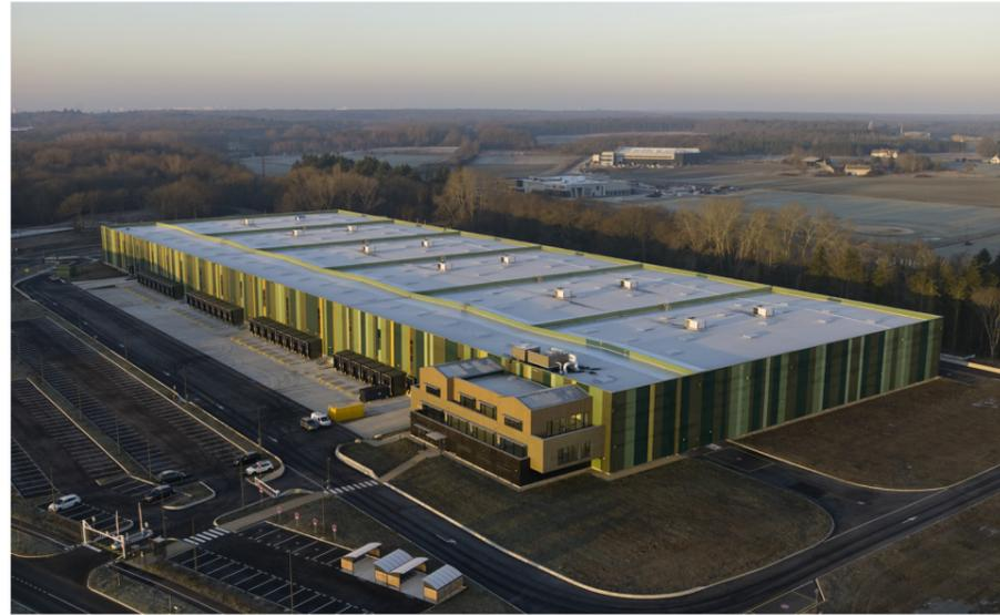
Il s'agit de la construction d'un bâtiment d'activités logistiques comprenant des entrepôts, des bureaux et des locaux techniques. Il comprendra 5 cellules dont 4 pour les produits inflammables, un ensemble de bureaux en R+2, un ensemble de locaux secondaires, un espace de stationnement VL et PL ainsi que toutes les dessertes nécessaires à la plateforme.
